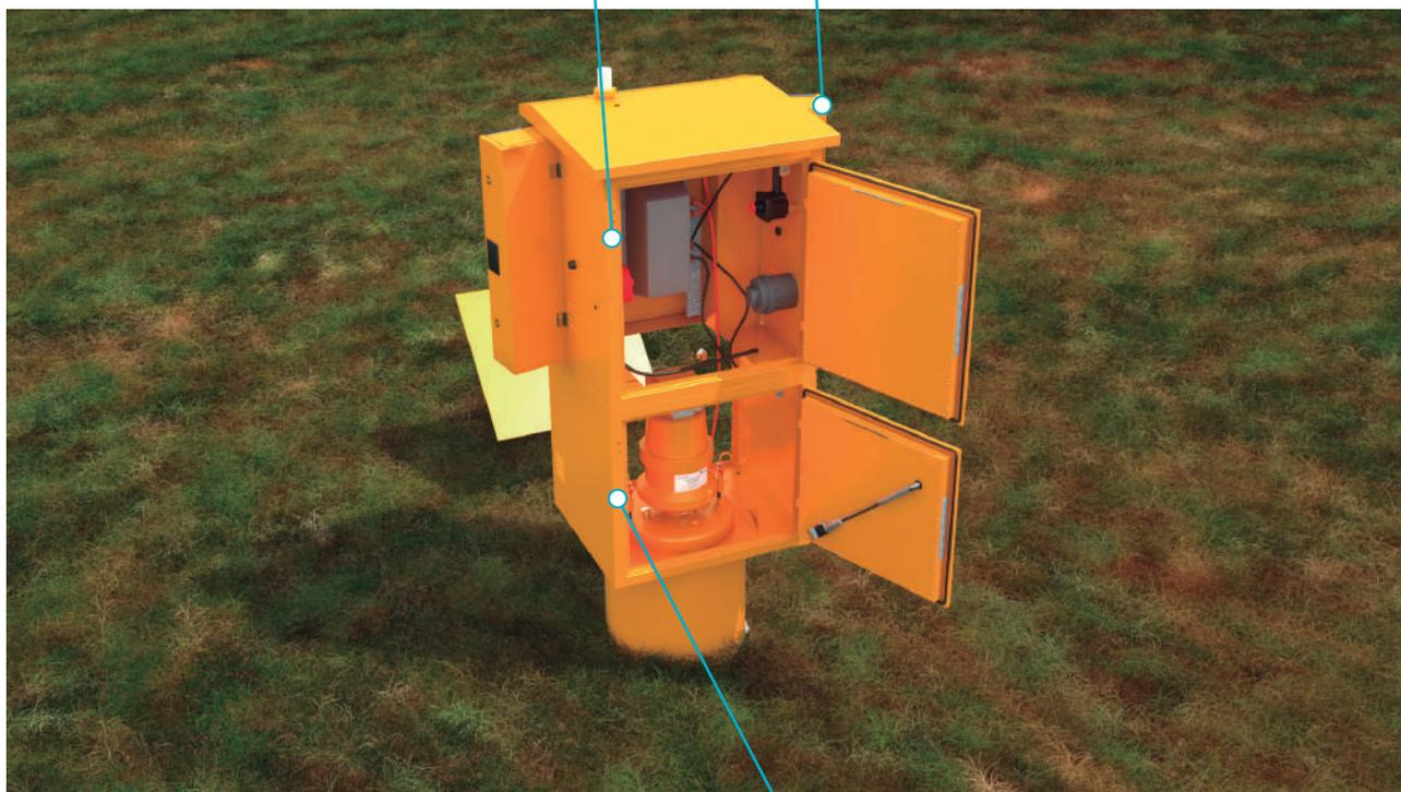
Нижний отсек технологического шкафа
