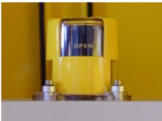
Рисунок 14. Визуальное устройство пневмогидравлического привода с отображением конечного положение шара крана
