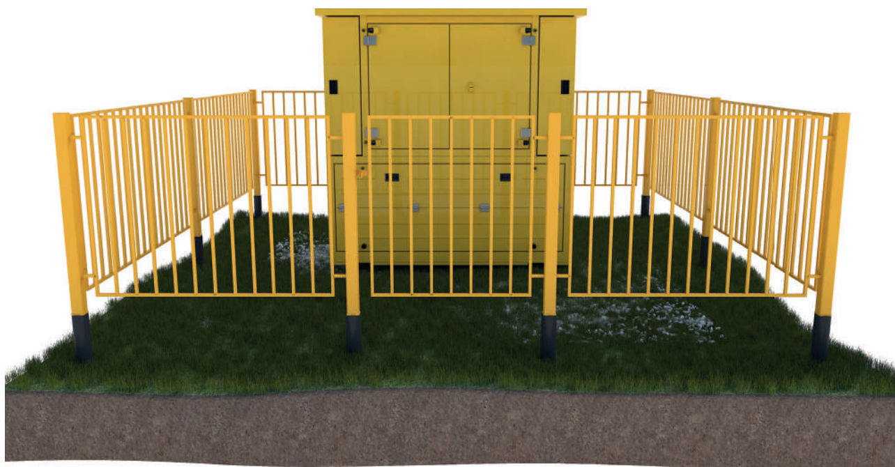
Рис. 1 - Модуль автономный крановый с пневмогидравлическим приводом ППГТ
